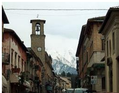
(Amatrice prima del terremoto)
